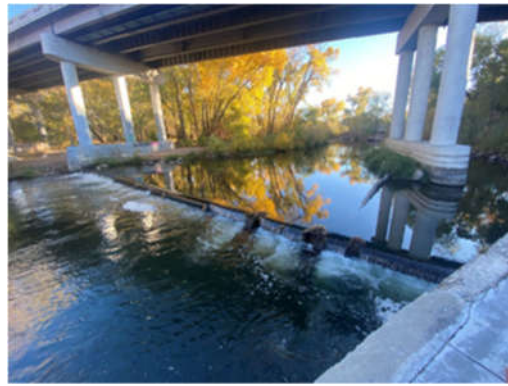
Wilson Canal Diversion
